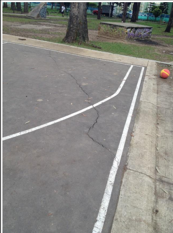
Fisura en asfalto costado nor oriental
