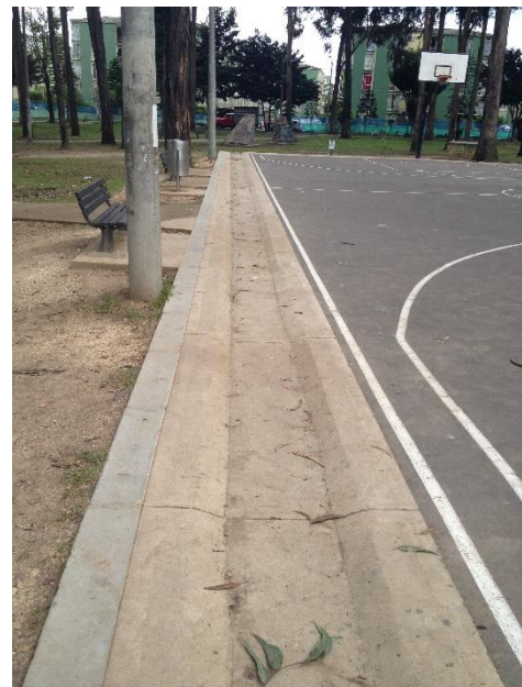
Cuneta costado occidental
