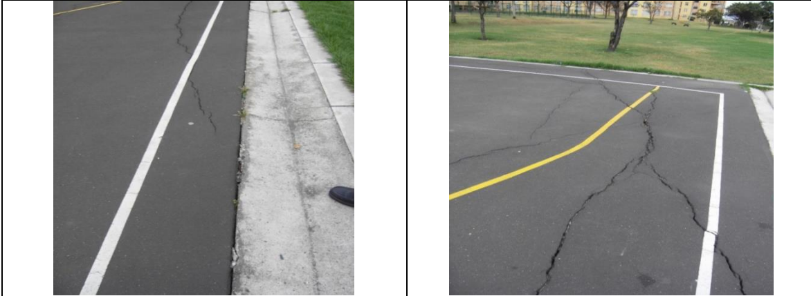
Notorias fallas de la estructura de la cancha construida, observando fisuramiento de la carpeta asfáltica y separación de la cuneta construida.
